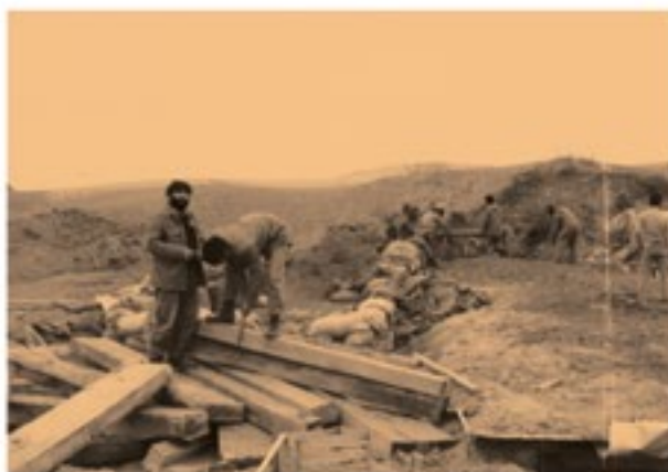
سازه پست امداد را با ایجاد حفره در تپه‌ها و گذاشتن تراورس روی سقف و چیدن گونی‌های خاک در ورودی‌ها درست می‌کردند.
